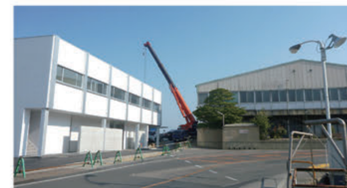
平成26年（2014年）12月 厚生棟と解体前の総合事務所
