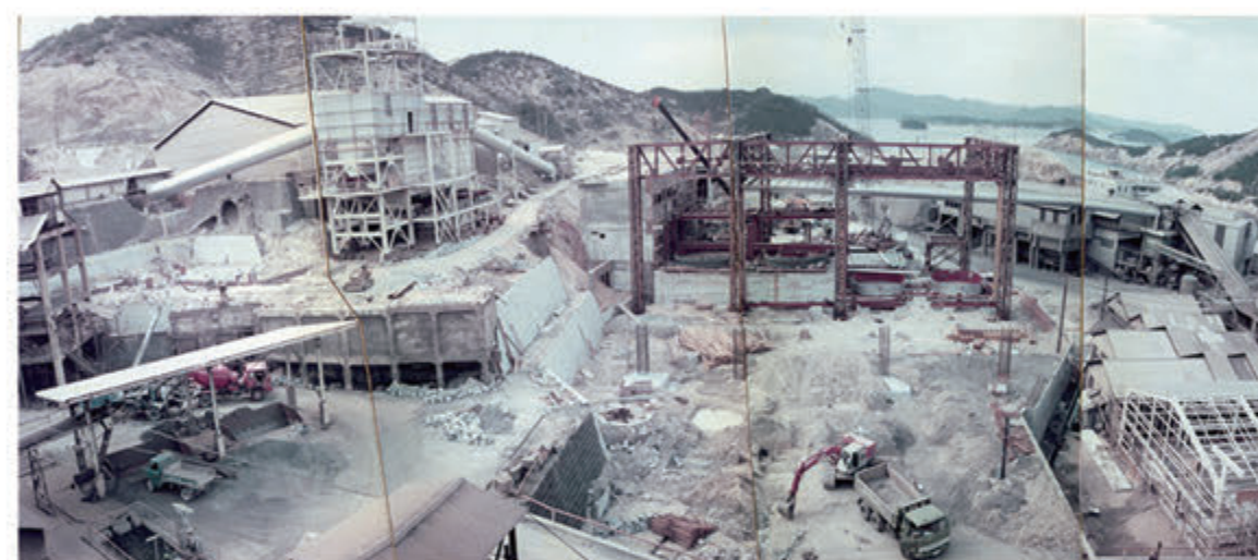
昭和48年（1973年）三菱連続製銅炉建設（現：香川県直島環境センター所在地）
