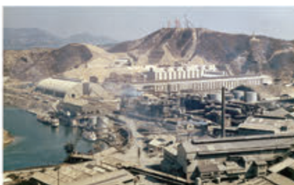
昭和44年（1969年）全景 高煙突が建設中
