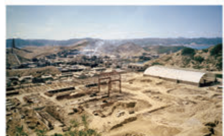
昭和43年（1968年）新製錬所建設（転炉工場建屋工事） 白屋根は鉄高相建設の貯蔵舎
