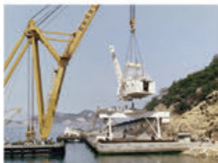
昭和43年（1968年）パスアンローダー建設
