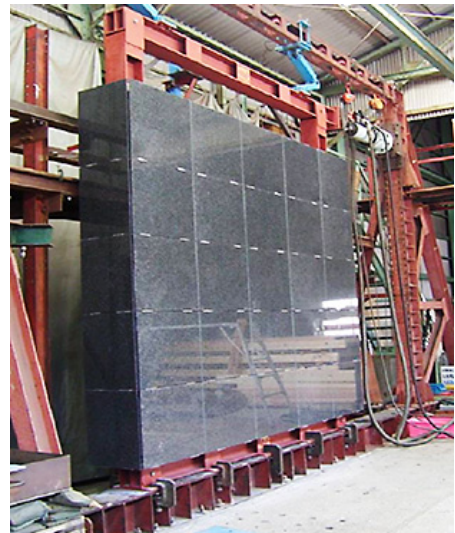
②左のフレームに外壁石板を取付施工後
