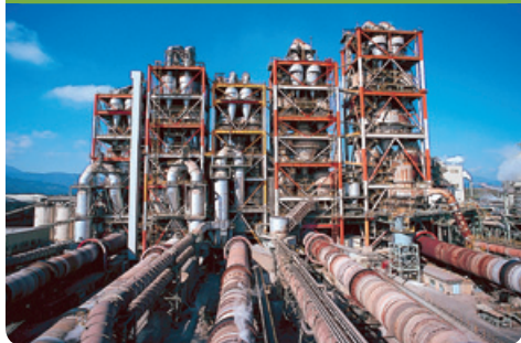
写真：九州工場（福岡県京都郡苅田町）
