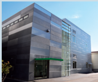
「安全衛生教育センター緑館」外観
