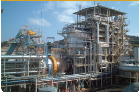
写真：金属リサイクル設備（直島製錬所）
