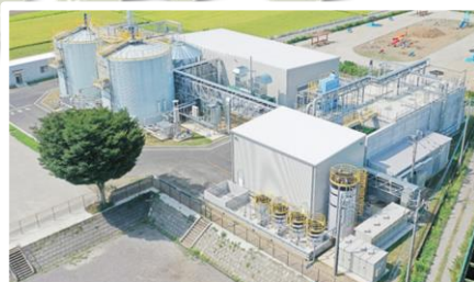
バイオガス： ニューエナジーふじみ野社営業運転開始（2020年9月）
