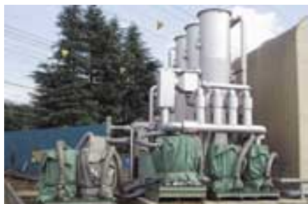
北本製作所での土壌浄化(揚水曝気装置)
