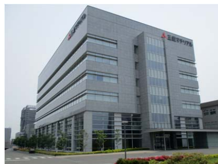
(地上部の状況)
