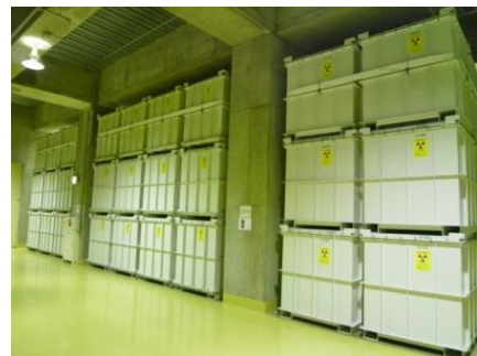
(地下2階の保管状況)
