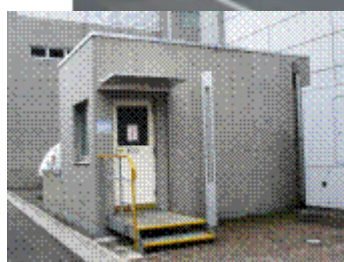
(新館東側の地下保管庫入口)
