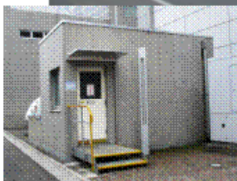
(新館東側の地下保管庫入口)
