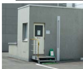
(新館東側の地下保管庫入口)
