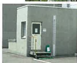
(新館東側の地下保管庫入口)
