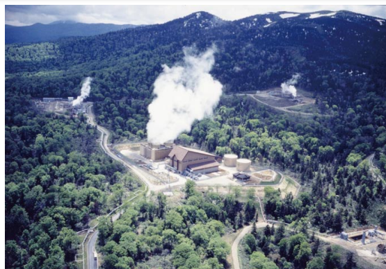
▲澄川地熱発電所 (50,000kW)
