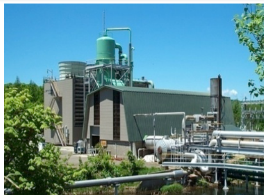
▲大沼地熱発電所 (9,500kW)
