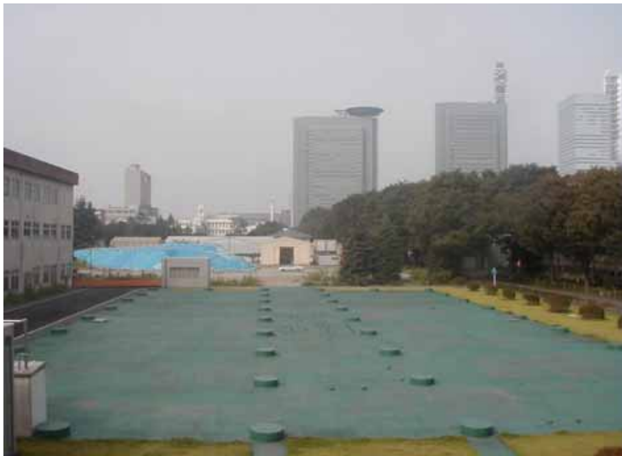
新保管庫（地下 1 ～ 2 階）の地上部分
